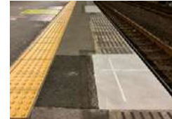
コンクリート・滑止め塗装
