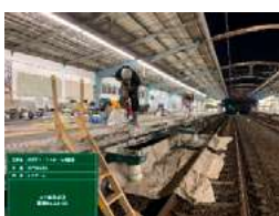
コア削孔、削孔水回収
